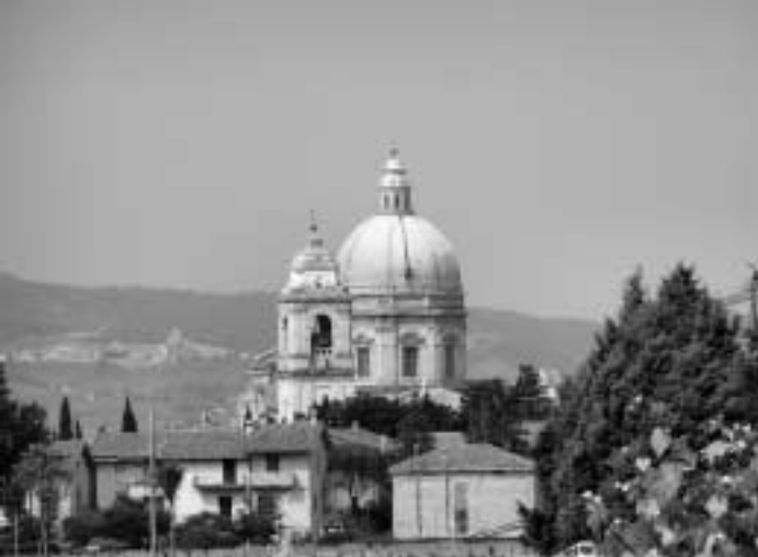
Santa Maria degli Angeli (med Porziuncola skjult indeni).
